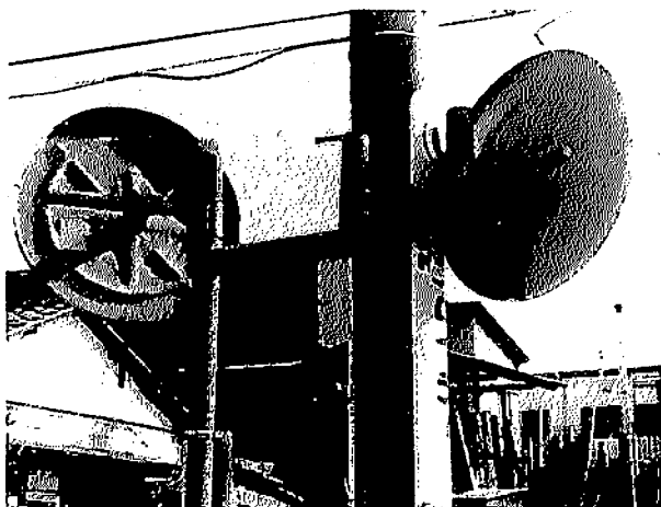
特別補助金具を使用して鏡面を電柱の右側に取りつけた安全設置の方法
