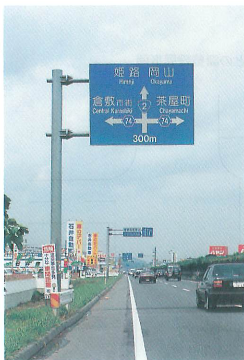
写真10. 指示案内標識の設置
