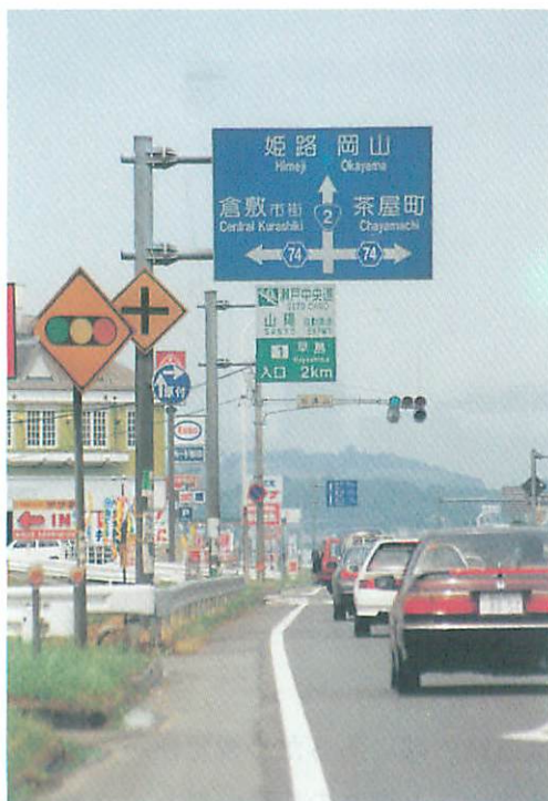
写真8. 予告案内標識の設置
