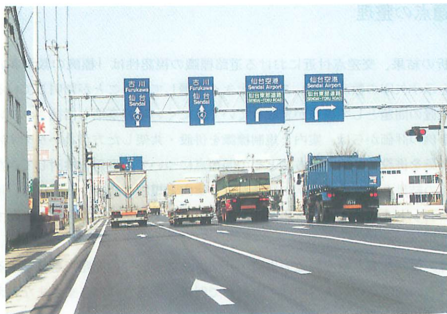
現行の設置状況（その１）
