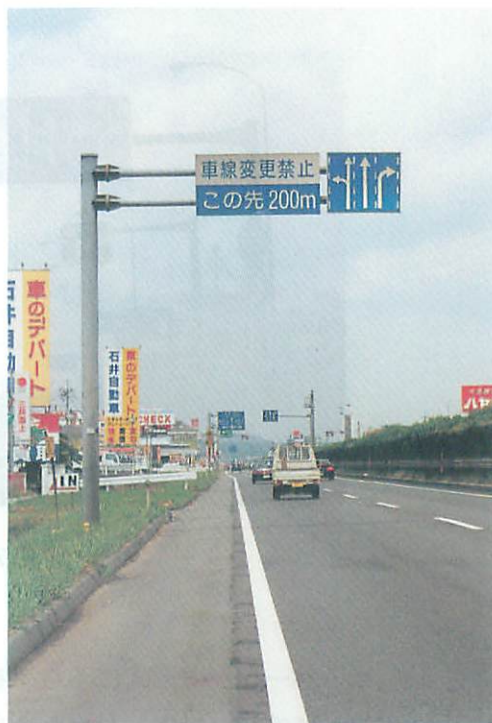
写真9. 規制予告標識の設置
