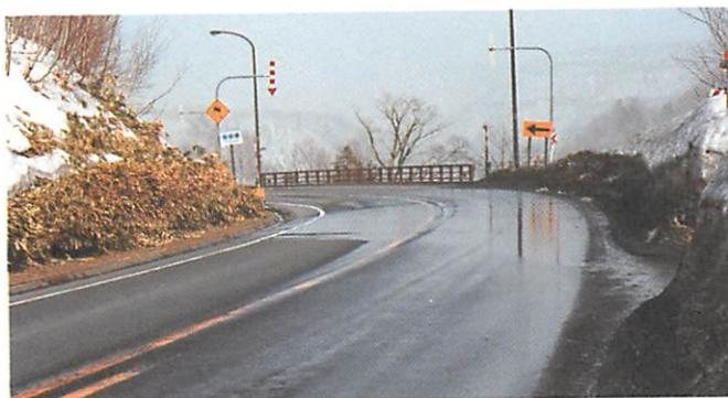
写真4. 1 融雪による路面冠水の状況（平成13年4月10日撮影）
