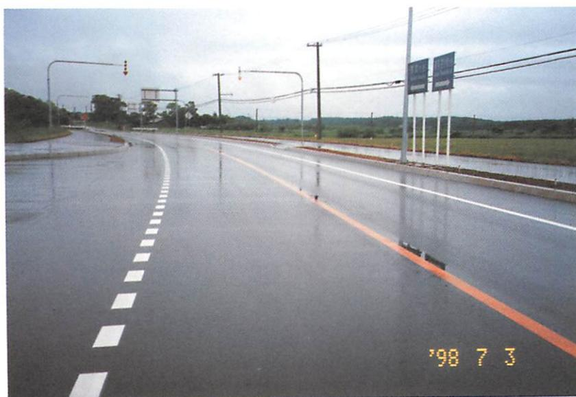
写真2. 13 カーブにおけるドット線の設置状況
