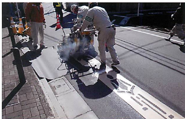
噴射工法にての施工状況
