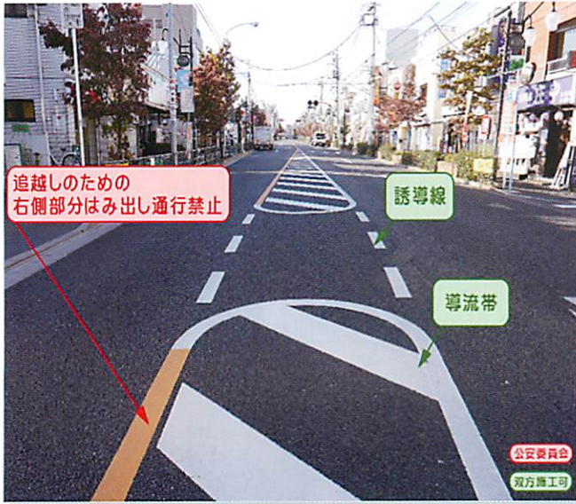
(道): 導流帯(107) (公): 追越しのための右側部分はみ出し通行禁止(102) 導流帯(208の2)
