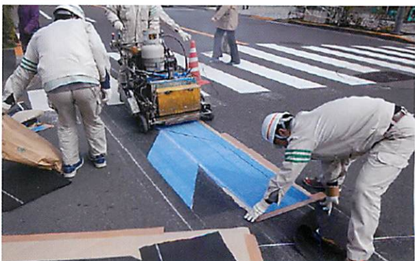
噴射工法にての施工状況 (右側)
