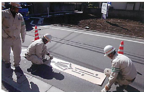
紙型枠設置状況
