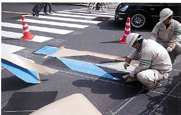
噴射工法にての施工状況 (右側)
