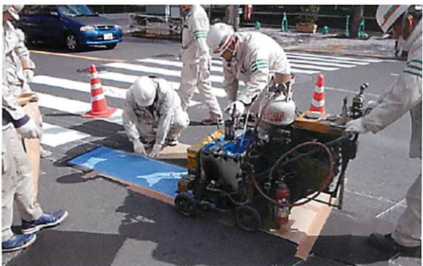
噴射工法にての施工状況 (左側)
