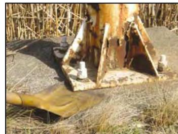
基礎面とベースプレートの隙間 評価9
