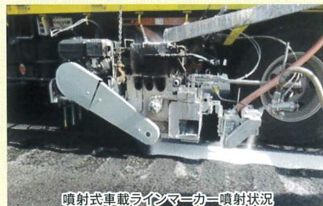
噴射式車載ラインマーカー噴射状況
