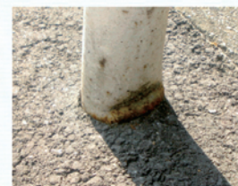
（支柱脚部亀裂〔変形〕一評価 9）
