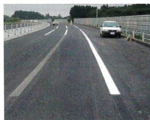
写真5 全天候性路面標示材の試験施工
