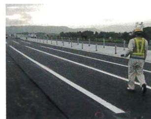
写真5 全天候性路面標示材の試験施工
